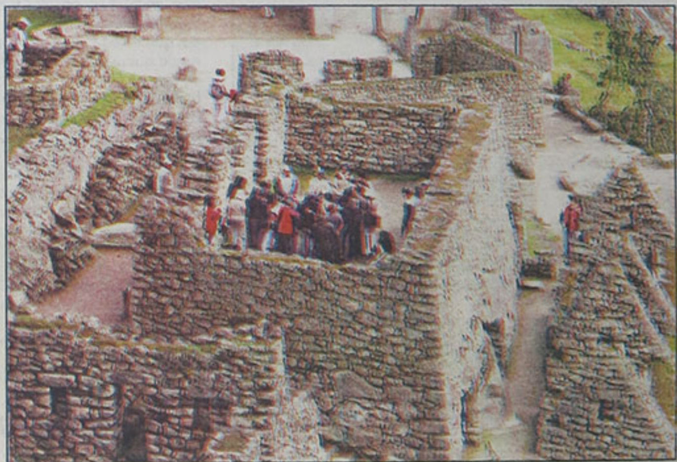
Este recinto se derrumbaría si se hacen las excavaciones que pretende el francés.
